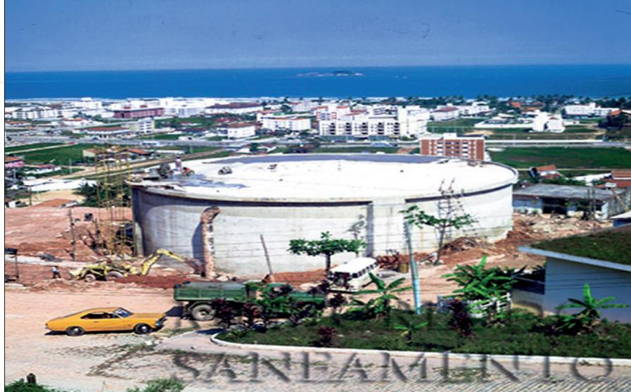
Reservatório de Concreto Protendido com 10.000 m<sup>3</sup>
